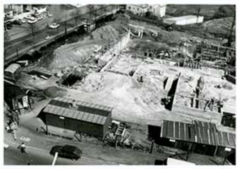
Fotos vom Baubeginn des Egerland-Kulturhauses Ende 1970
